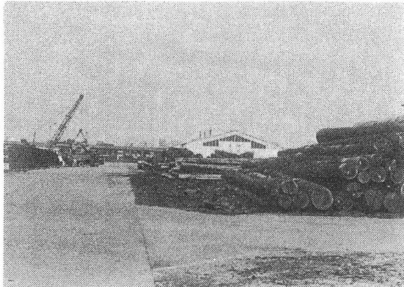
写真A 千葉港 原木置場付近
